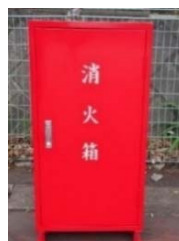
初期消火箱（固定式）
