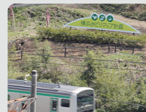
線路沿いでの現地表示看板の設置
