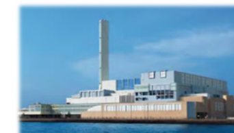
工場の新設・長寿命化工事
